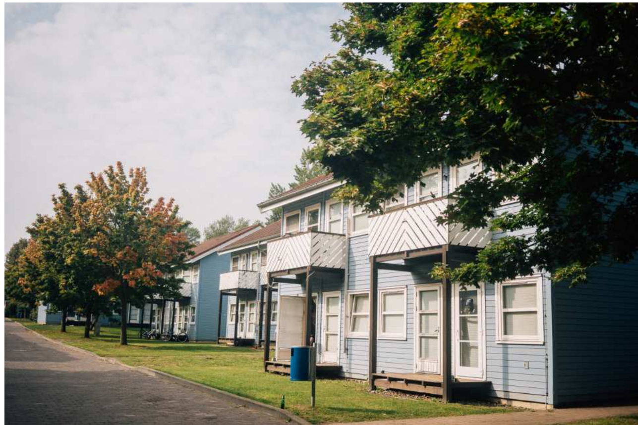
Ein Teil der Häuser in der Wohnheimanlage Holzhausen soll in den kommenden Jahren zurückgebaut werden, sodass Neubauten entstehen können.
